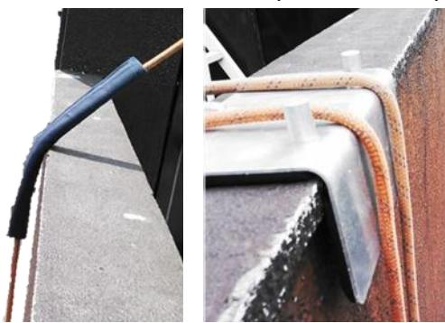
切断防止措置の例 (巻き型養生) ▲
